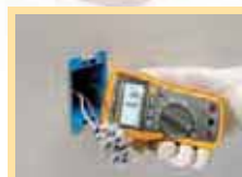
Reparación o mantenimiento
