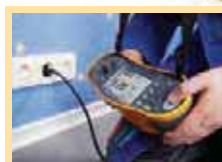
Comprobación de instalaciones eléctricas
